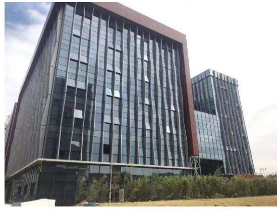
主体工程现状
